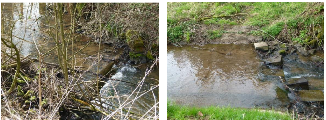
Abbildung 19: Sohlsicherungen am Röthenbach
