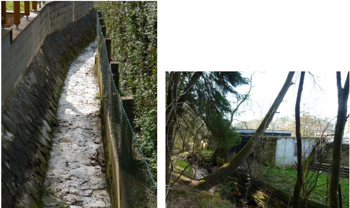
Abbildung 16: Ufermauern und Ufersicherungen an der Röst
