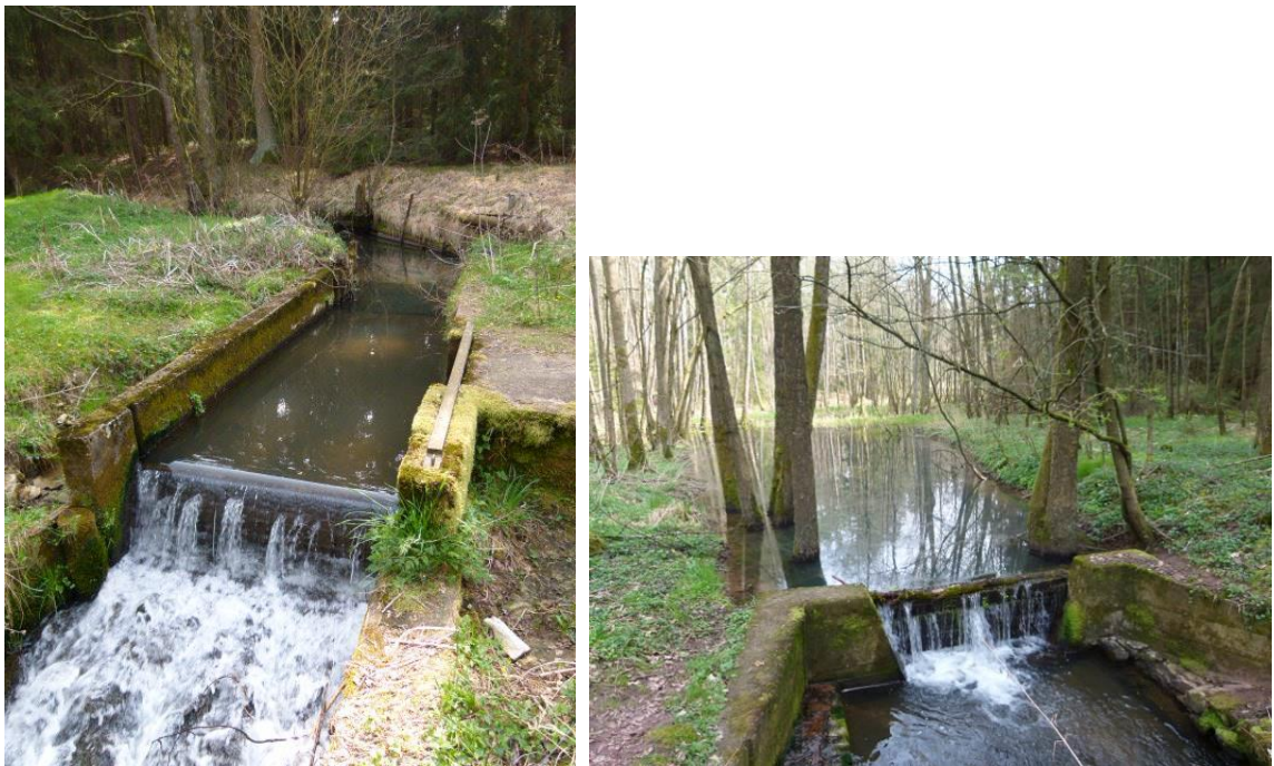
Abbildung 18: Querbauwerke am Röthenbach
