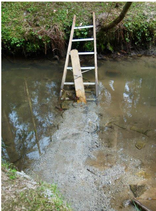
Abbildung 22: Betonarbeiten im Gewässer der Röst, Bauschutt am Ebenbach
