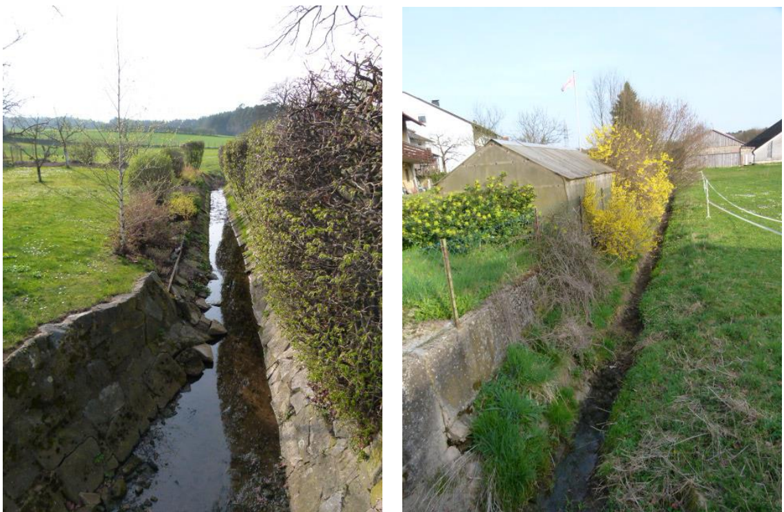
Abbildung 15: Gewässerausbau am Ebenbach
